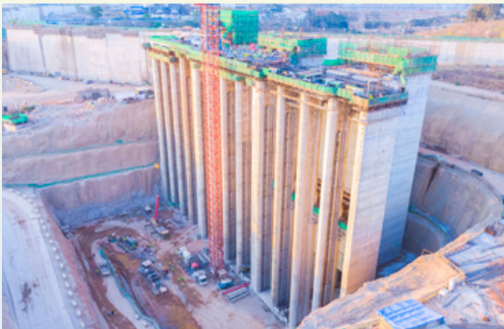
Sehemu ya mradi wa JNHPP ambapo maji yatapita kwenda kuzalisha umeme (Waterhouse) ikiwa katika hatua za mwisho kukamilika kama inavyoonekana kwenye picha.
