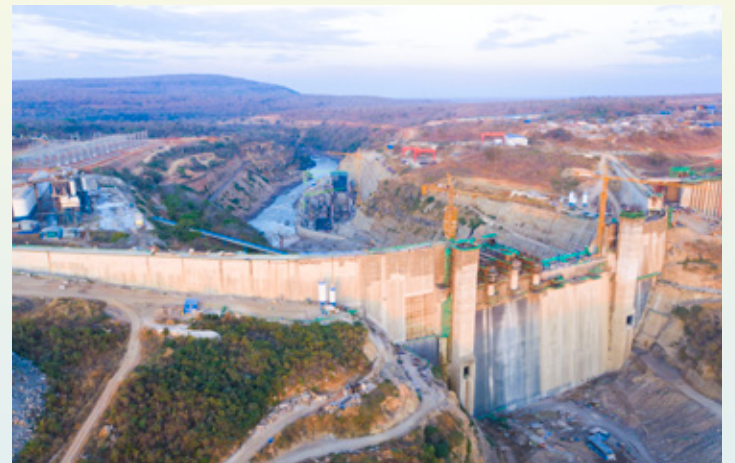
Sehemu ya mradi wa JNHPP ambapo maji yatatunzwa kwenda kuzalisha umeme (Main Dam) ikiwa katika hatua za mwisho kukamilika kama inavyoonekana kwenye picha.
