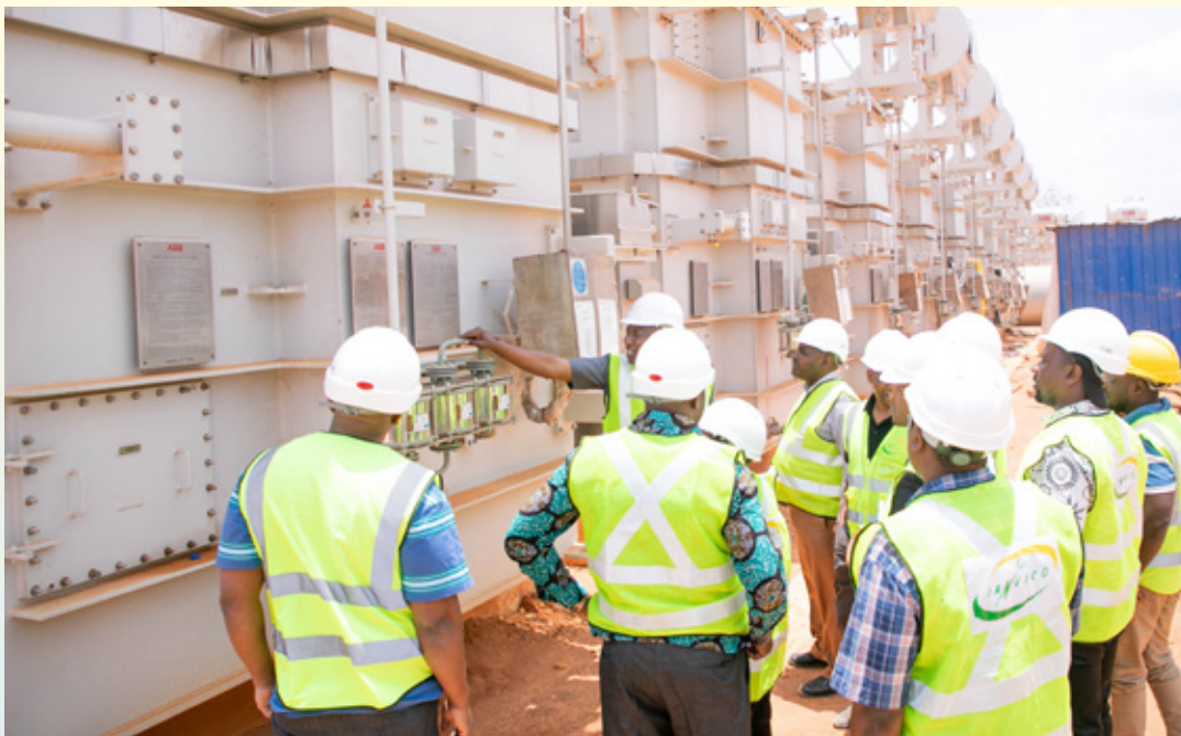
Kamati ya Kudumu ya Bunge ya Nishati na Madini, ikiangalia Transfoma zitakazotumika Katika mradi wa kuzalisha umeme wa JNHPP, mara baada ya kutembelea mradi huo Oktoba 15, 2022.
